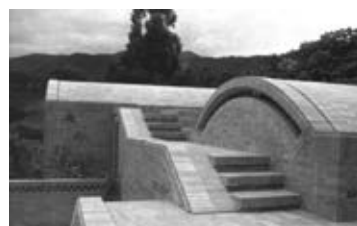
Figura 11. Escalera en la cubierta del ala norte.
