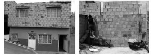
Foto 1. Vivienda informal en sectores vulnerables de Bogotá
