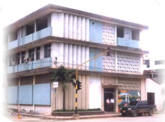
Fotografía No. 1: Fachada de la Biblioteca David Martínez
