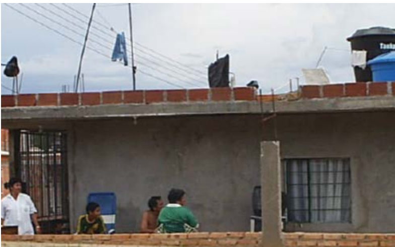
Figura 2. Construcción de muro de cerramiento en viviendas del proyecto Torcoroma I
