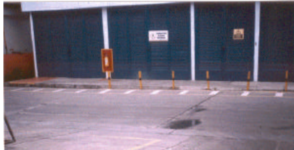
Figura 19. Celdas de media tensión y transformadores.
