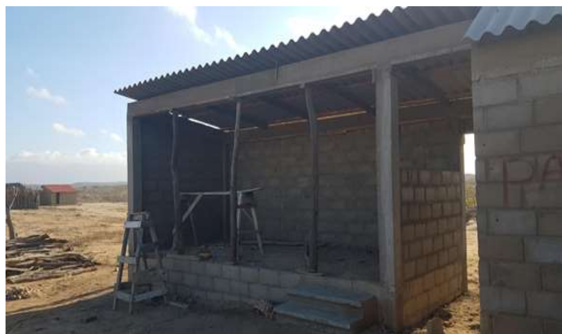
Figura 13. Templo en Etapa Final de Construcción.
