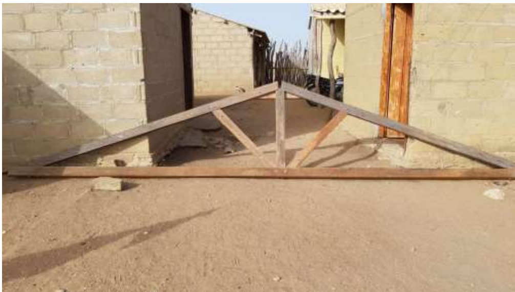
Figura 14 Estructura en madera para el techo del Templo Comunitario.
