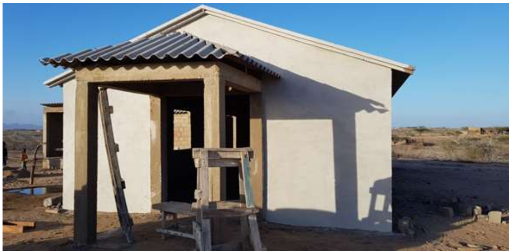
Figura 15. Templo en Etapa Final de Construcción. Fuente: Elaboración propia (2018).
