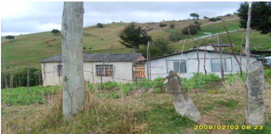
Figura 2. Construcciones de vivienda
