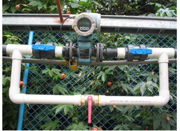
Foto 2 Traslado del medidor de flujo a la alimentación del DAF
