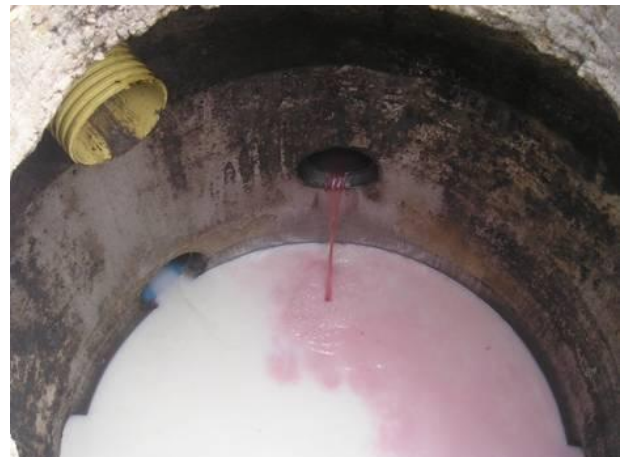
Foto 4 Identificación de vertimiento en pozo de inspección con anilina
