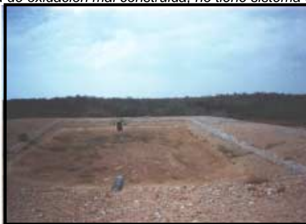
Foto 5. Laguna de oxidación mal construida, no tiene sistema de impermeabilización.
