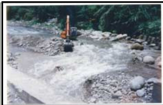
Foto 8. Mantenimiento de la fuente Río Las Ceibas
