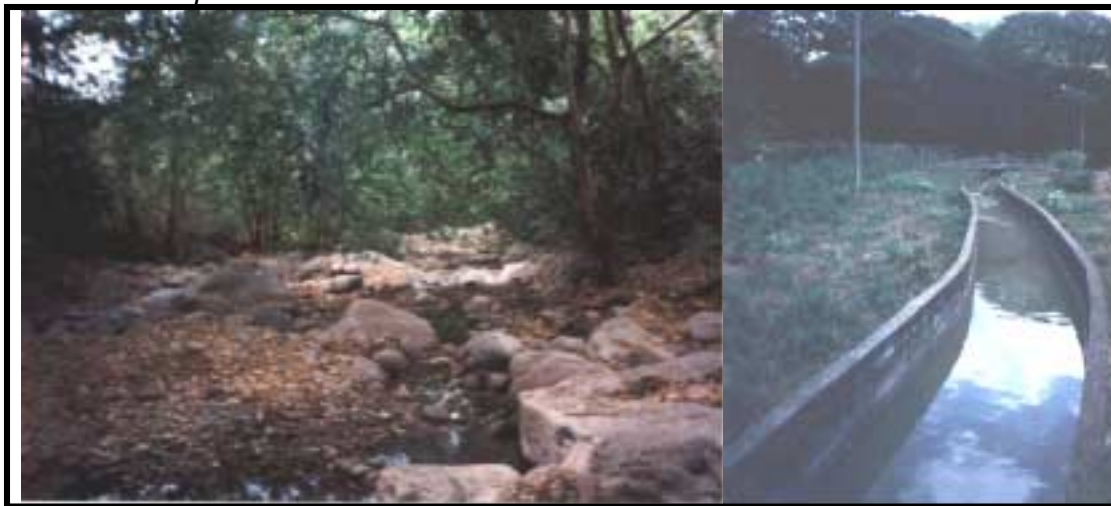
Foto 4. (a) Fuente de abastecimiento en estado de sequía. (b) Transporte de agua de mala calidad por la aducción.
