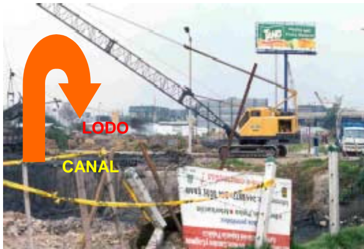
Foto 18 Aislamiento de obra
