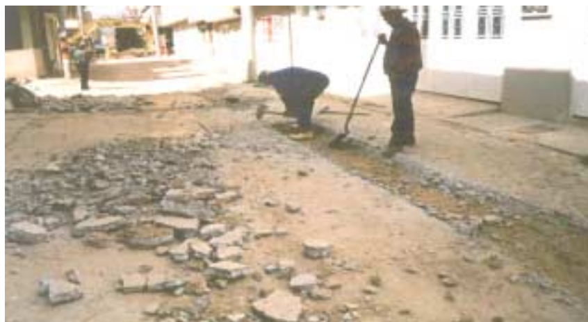
Foto 9 Excavación manual
