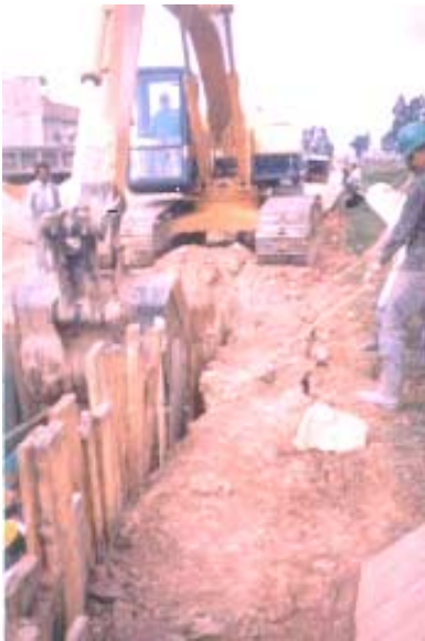
Foto 8 Retroexcavadora ejecutando las labores de excavación.
