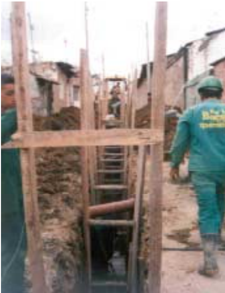
Foto 13 Entibados en madera
