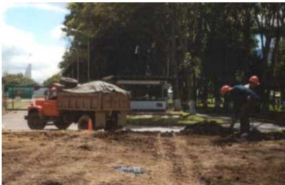
Foto 4 Excavación manual
