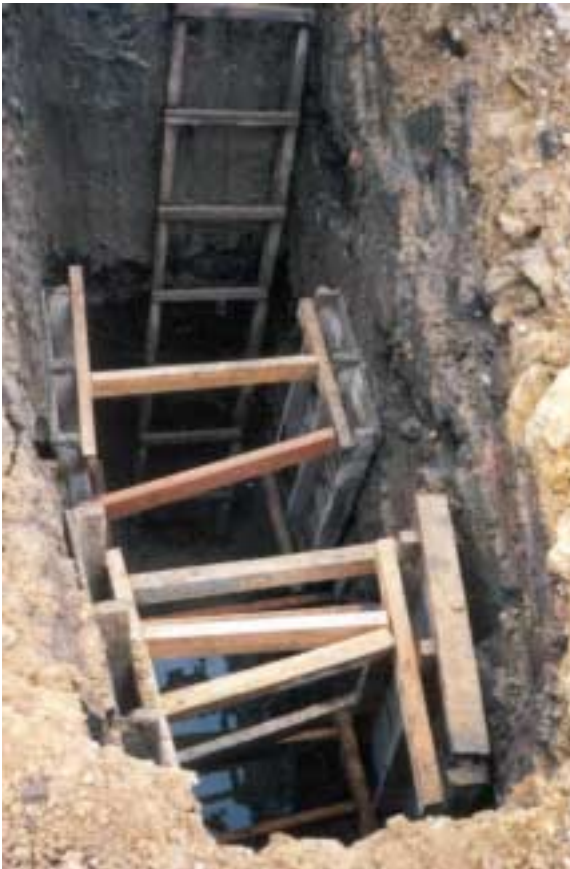
Foto 7 Excavación en pozo
