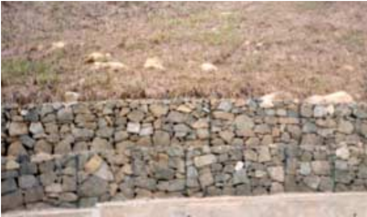
Foto 11 Muro en Gaviones
