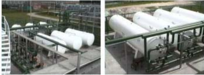
Foto 5. 1. Batería de Filtración para Clarificadores de 50 L – 2. Batería de Filtración para Clarificadores de 75 L.
