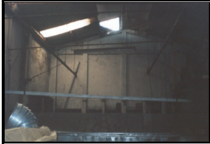
Foto 1. Zona de anodizado
