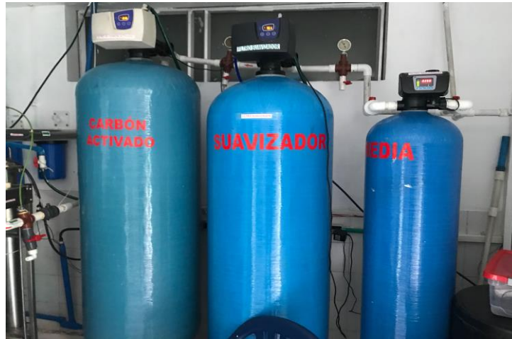
Ilustración 12. Filtros de carbón activado. Fuente: Autores
