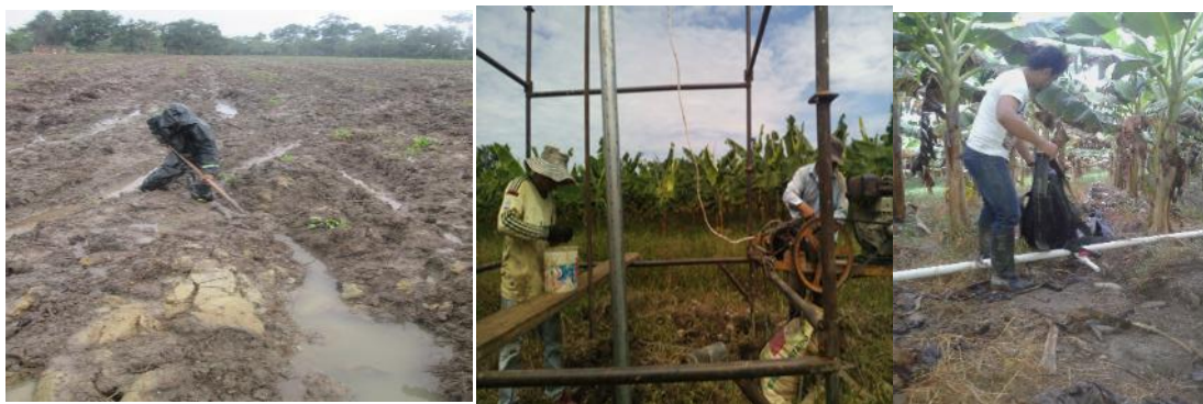
Figura 1. Implementación de riego y drenaje
