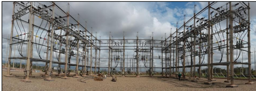
Ilustración 5: Pórtico Quifa Sur Oeste
