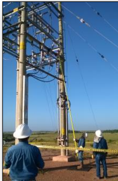
Ilustración 7: Estructura tipo Portico de llegada a Cluster
