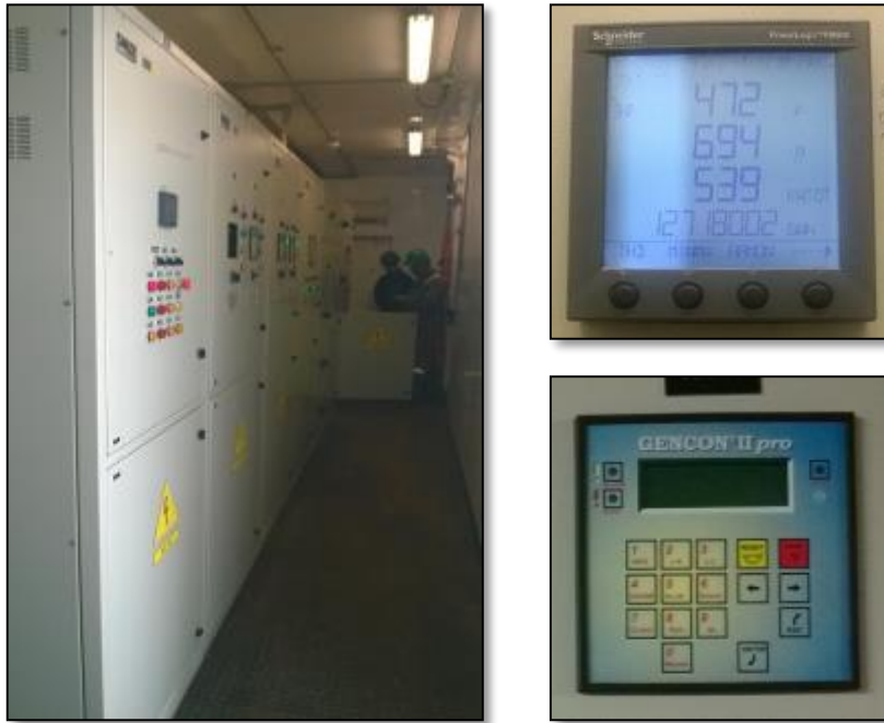
Ilustración 10: Barra de acople Generadores y Red Eléctrica
