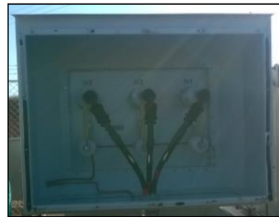
Ilustración 8: Transformador Reductor 34,5 a 480/277 V. Dyn5
