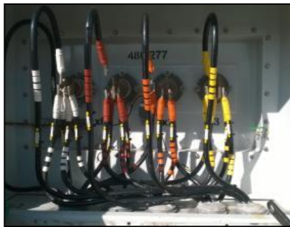
Ilustración 8: Transformador Reductor 34,5 a 480/277 V. Dyn5
