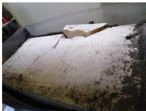
Figura 24. Falla del sistema placa – pilote. Fuente: Autores.
