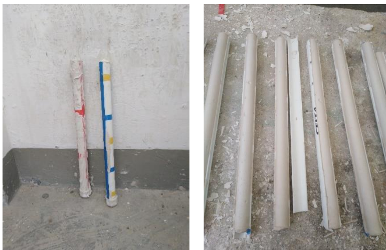
Figura 8. Construcción de los pilotes.
