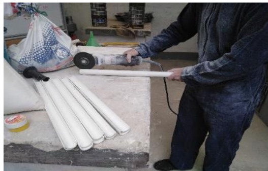
Figura 3. Construcción de las formaletas de los pilotes.
