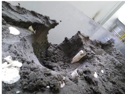
Figura 26. Excavación del sistema de placa – pilote.
