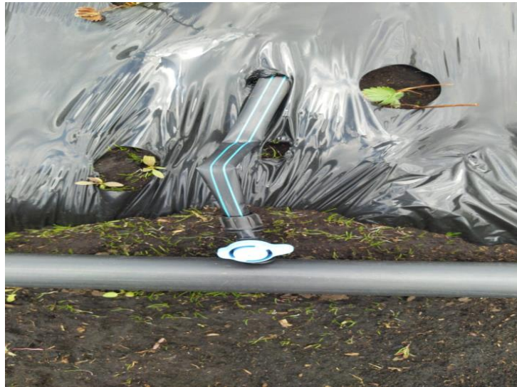
Imagen 4. Adecuación de sistema de riego
