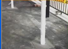
SE OBSERVAN LAS BASES DE LAS ESTRUCTURA DE LAS CANCHAS DE BALONCESTO Y MICROFUTBOL.
