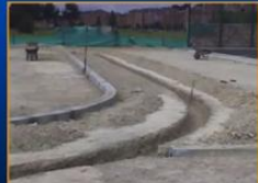
SE REALIZO LA EXCAVACION PARA LA POSTERIOR FUNDICION DE LA VIGA ALREDEDOR DEL PATINODROMO (27CM AL LIMITE DEL RECEO COMPACTADO).
