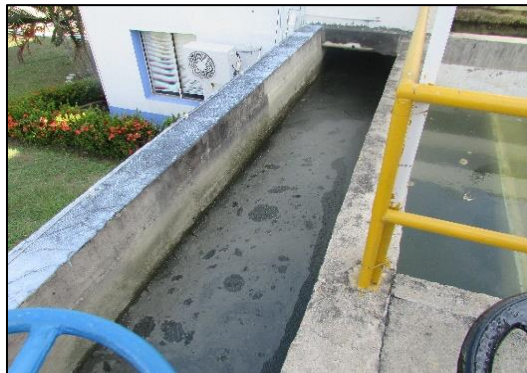
Imagen 11. Agua en proceso de tratamiento Fuente: Autores.
