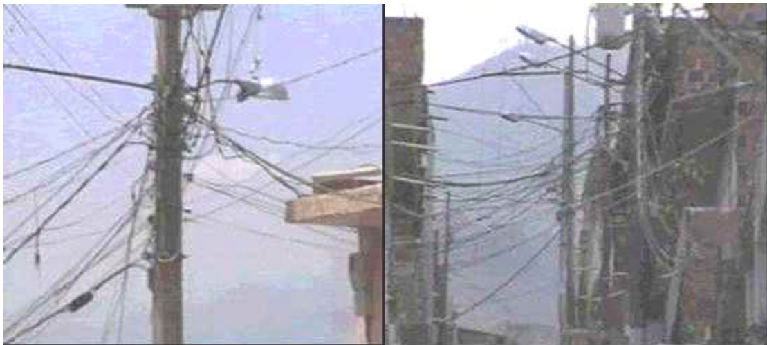
Figura 27. Remodelación de redes
