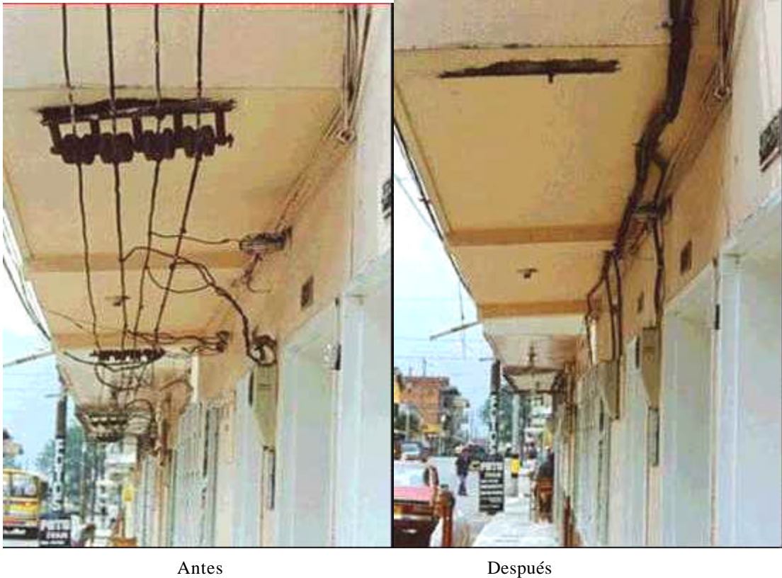
Figura 28. Remodelación de acometida
