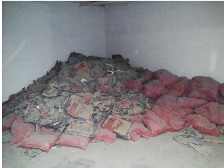
Figura 7. Almacenamiento de bolsas de mortero
