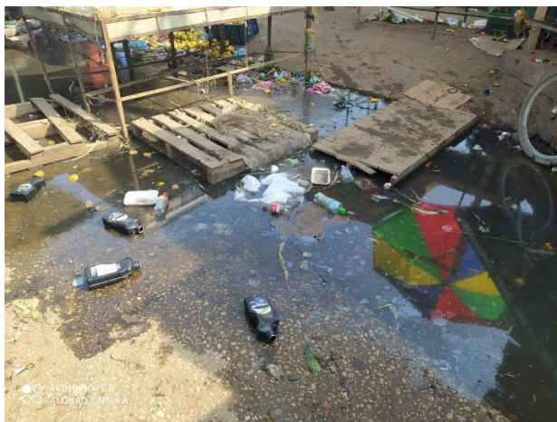
Figura 9. Acumulación de lixiviado por taponamiento de cunetas
