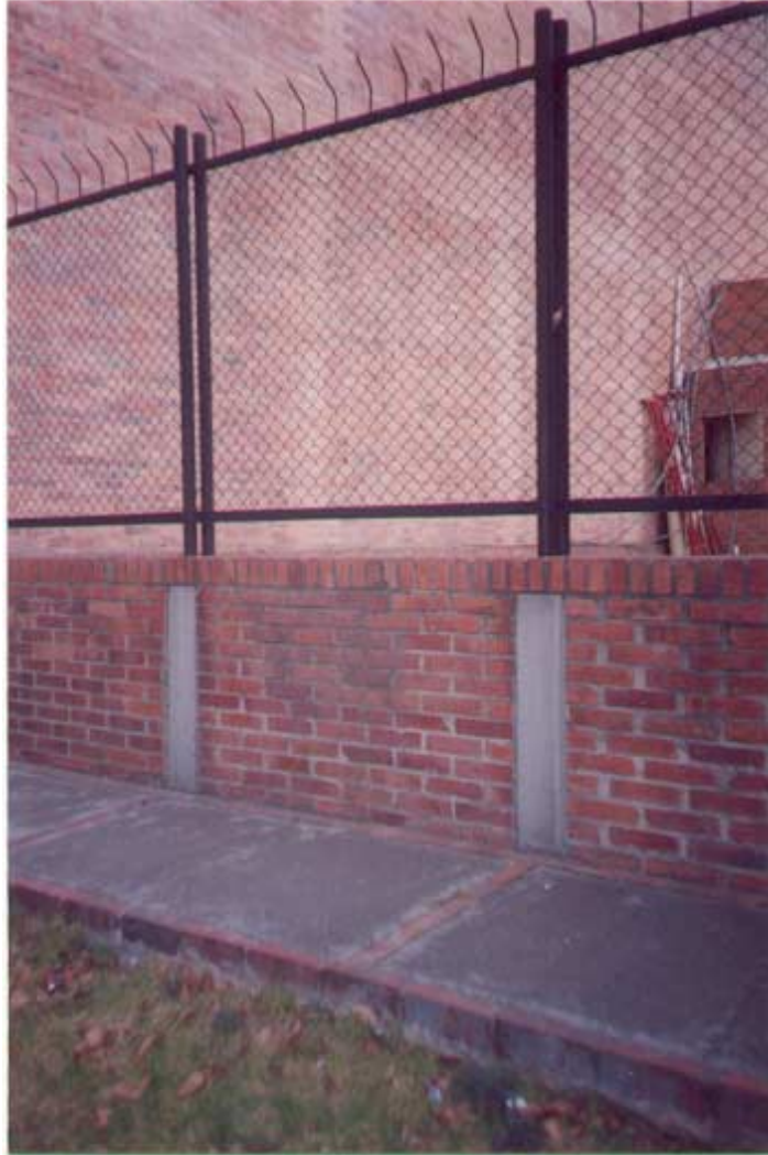
Figura 2. Cerramiento en malla.
