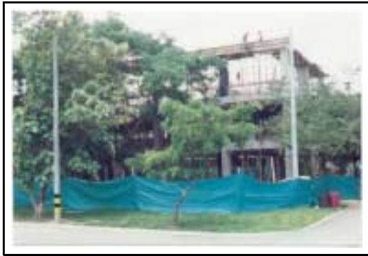
Figura 11. Señalización con malla fina sintética.
