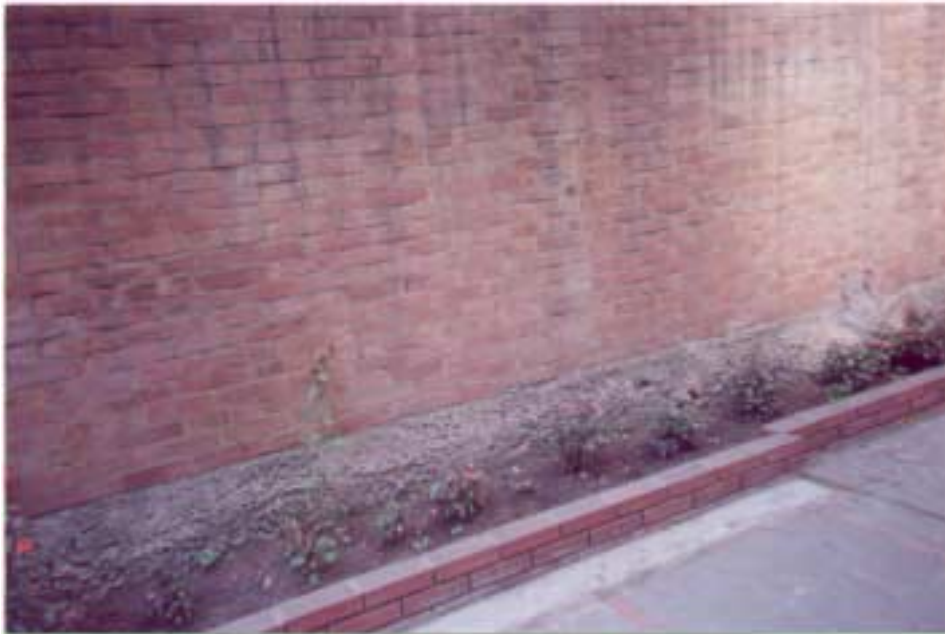
Figura 1. Cerco con muro en mampostería.
