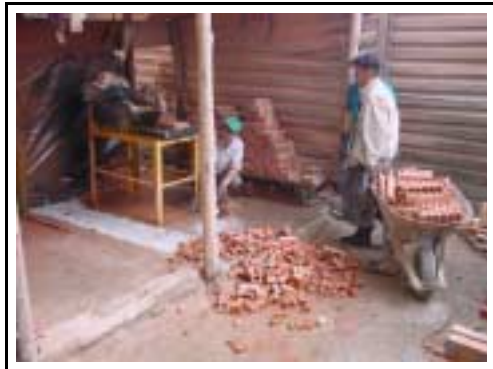
Figura 8. Encerramiento para atenuar ruido de la cortadora.
