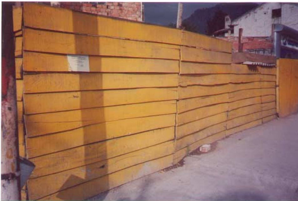
Figura 4. Cerramiento en madera.
