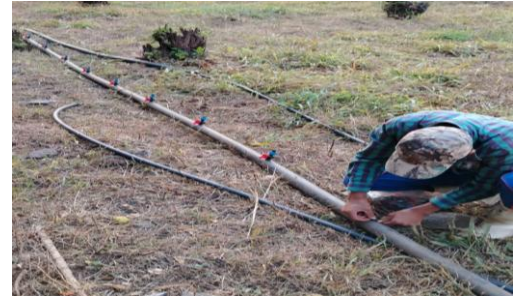
Figura 4. Instalación del sistema de riego.
