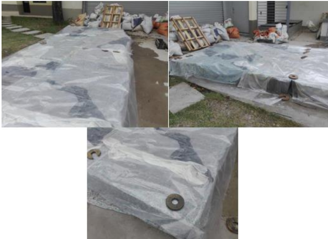
Figura 21 Proceso de curado de los especímenes de concreto.
