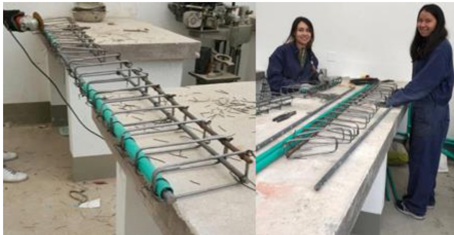
Figura 9 Preparación de las armaduras
