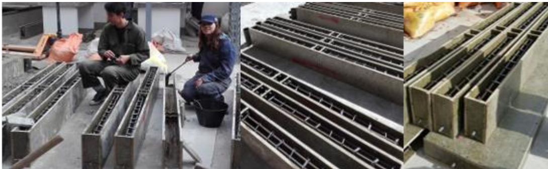
Figura 15 Formaletas y armaduras.
