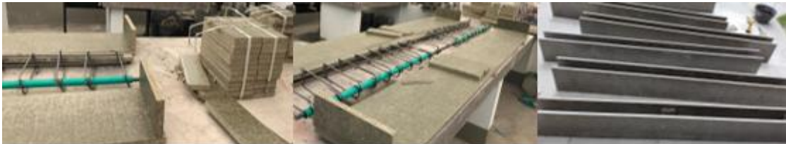
Figura 13 Armado de formaletas .
