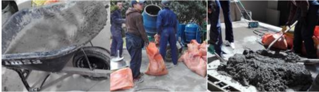
Figura 16 Mezcla de los materiales para producir el concreto.
