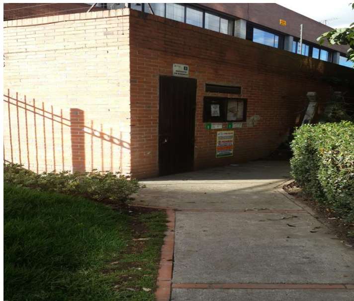
Figura 4. Vista exterior depósito de basura, conjunto residencial LAS MERCEDES de Suba
