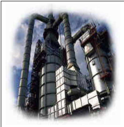
Foto 58. Planta de tratamiento de aceite usado.
