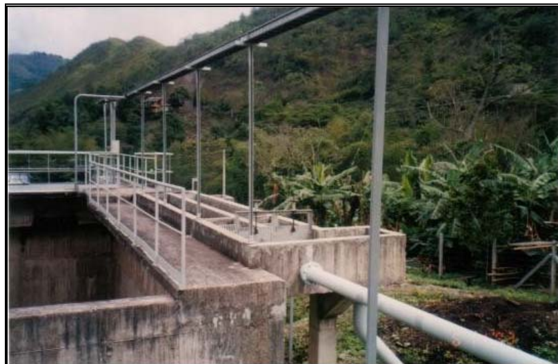
Obra De Llegada Planta De Tratamiento Aguas Residuales
