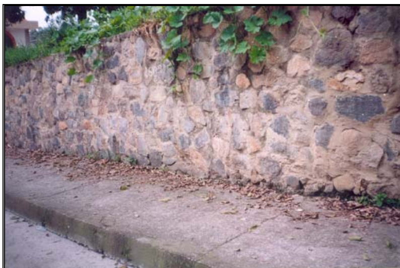
Presencia De Residuos En Los Costados De La Autopista Medellín
