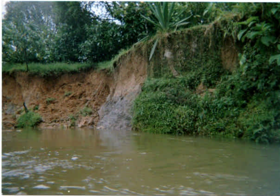
FOTO #6, Perdida de la cobertura vegetal por la erosión.
