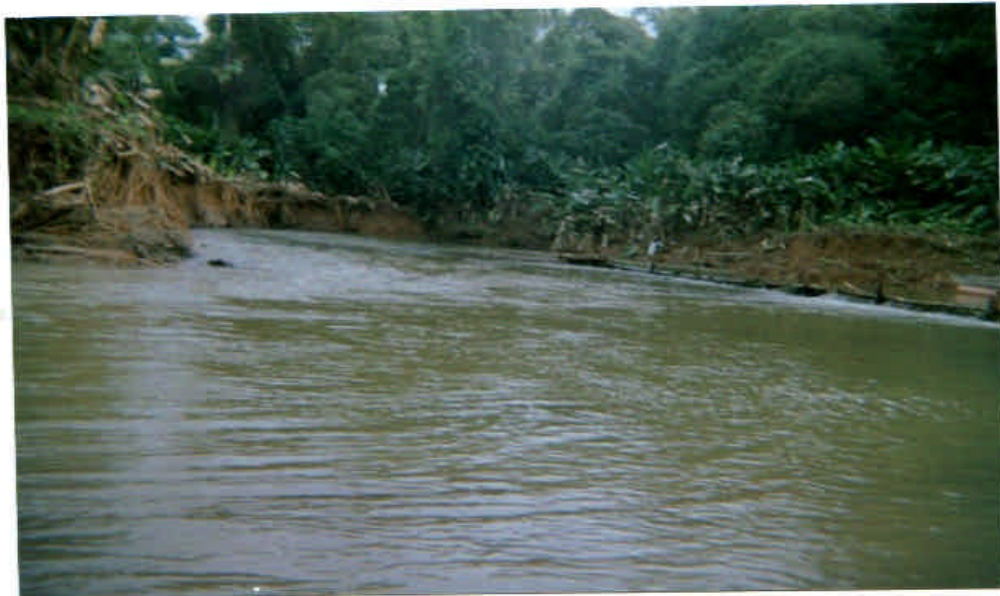
FOTO #10, Cambio en la morfología de la cuenca por socavamiento de los taludes.
