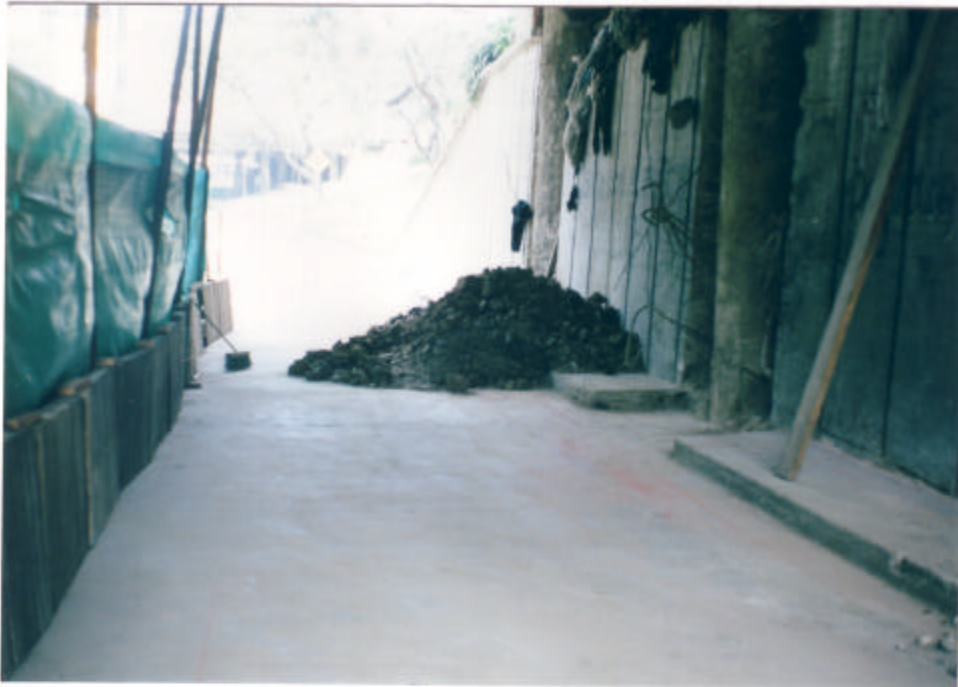
Foto 1. Acumulación de material de excavación.
