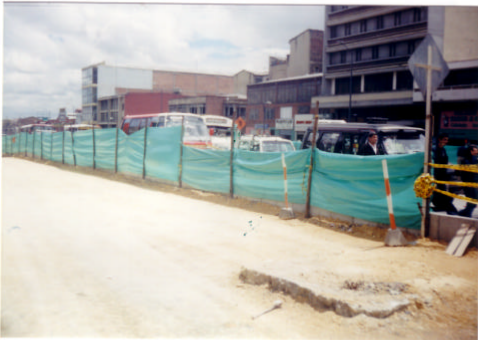
Foto 6. Malla de aislamiento.
