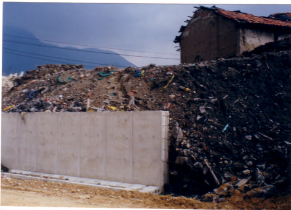
Foto 2. Acumulación de material de excavación.
