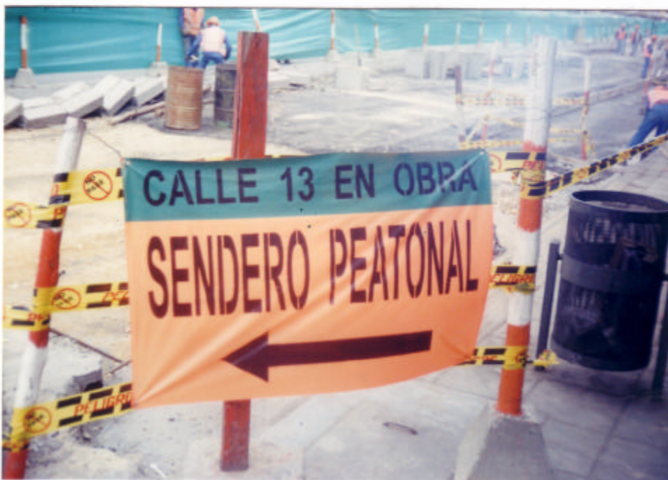
Foto 2. Señalización en obra.
