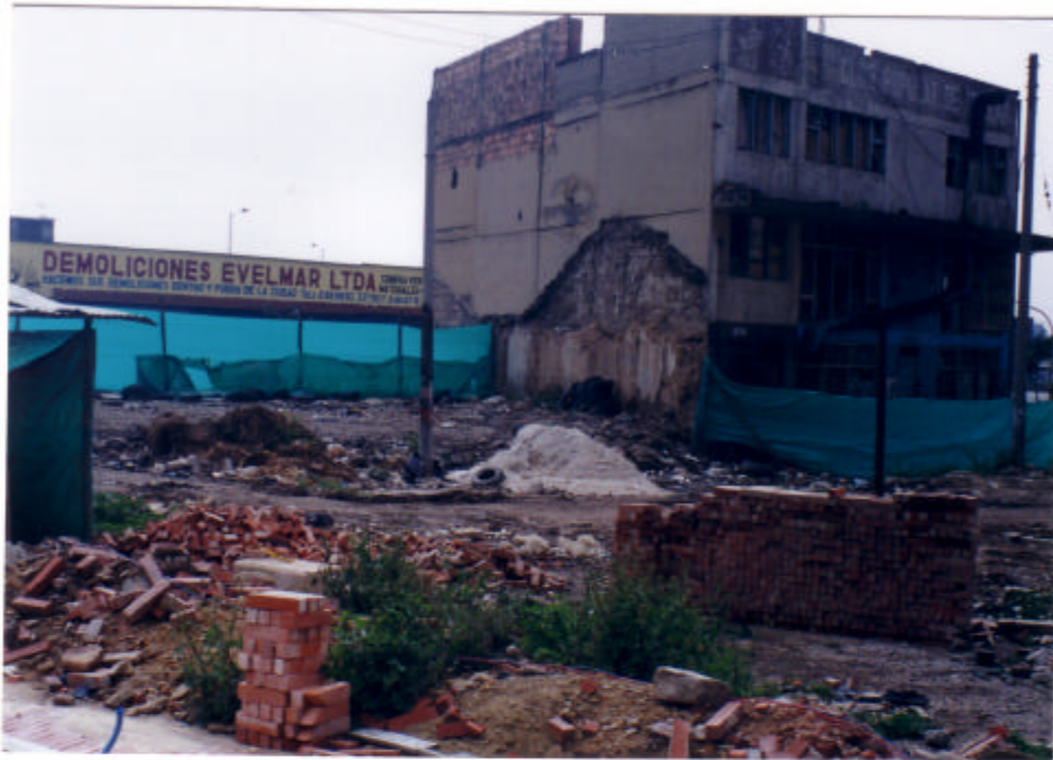
Foto 1. Sector en obra.
