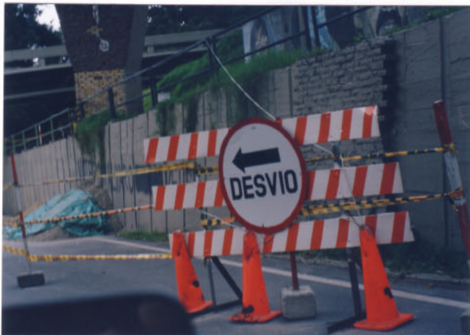
Foto 2. Señalización y manejo de tránsito.
