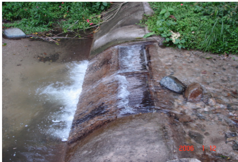
Figura 4. Fotografía Bocatoma Quebrada Camenzo
