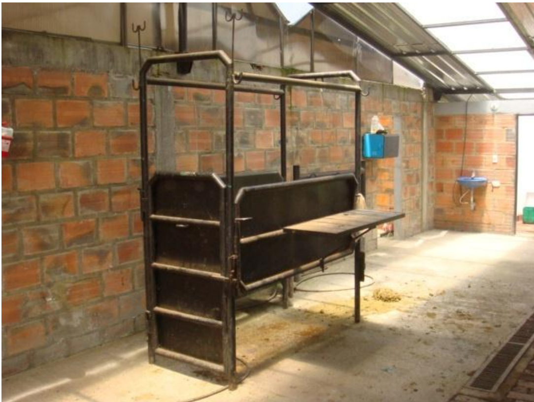
Figura 18. Brete Fuente: Arévalo, Rico 2012
