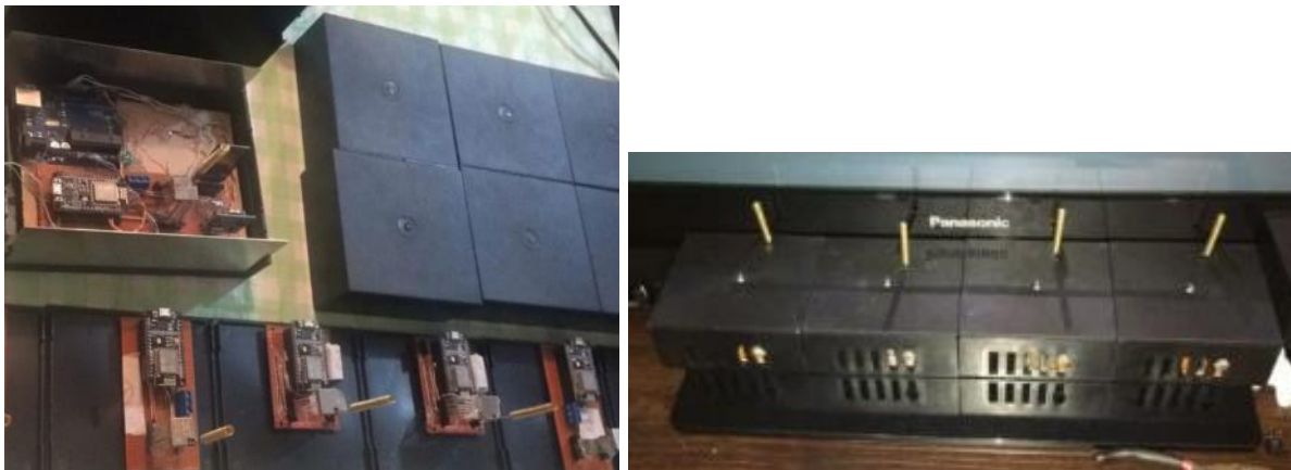
Figura 31 Montaje de las cajas circuitos de transmisión de datos
