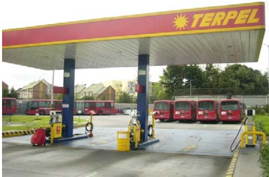
Fotografía 3. Estación de servicio
