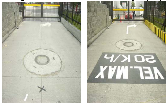
Fotografía 26. Señalización de tránsito (antes y después)
