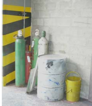
Fotografía 6. Almacenamiento de gases para soldadura
