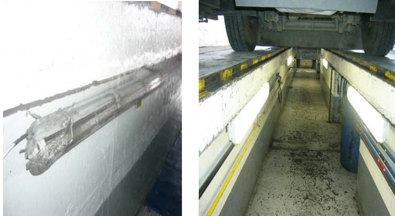
Fotografía 20. Recuperación de luminarias (antes y después)
