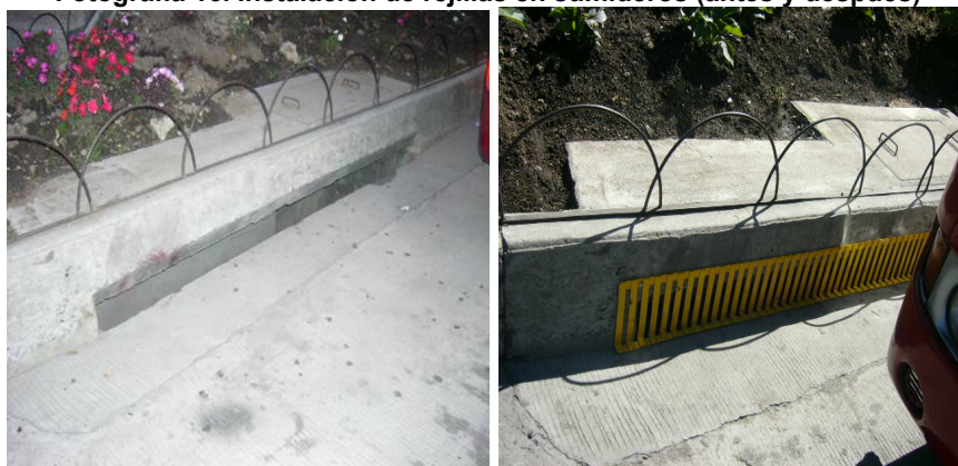
Fotografía 16. Instalación de rejillas en sumideros (antes y después)
