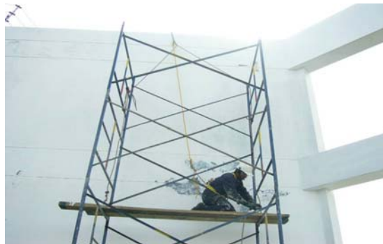
Fotografía 24. Trabajo seguro en altura y uso de elementos de protección
