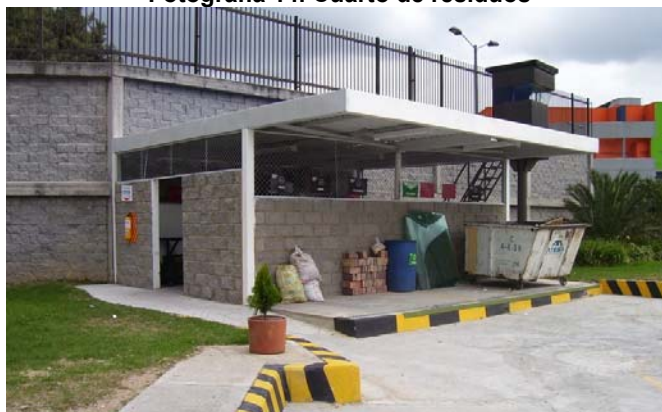
Fotografía 14. Cuarto de residuos
