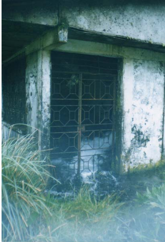
Figura 7. Vista frontal de la casa de máquinas.
