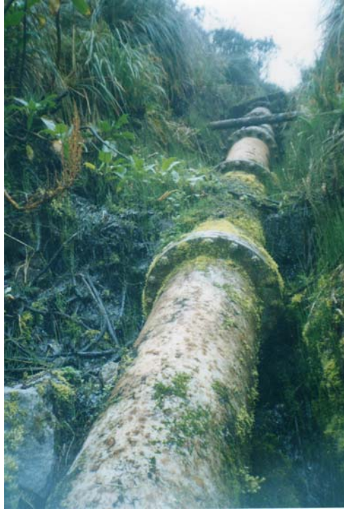
Figura 6. Vista frontal de la tubería de carga.
