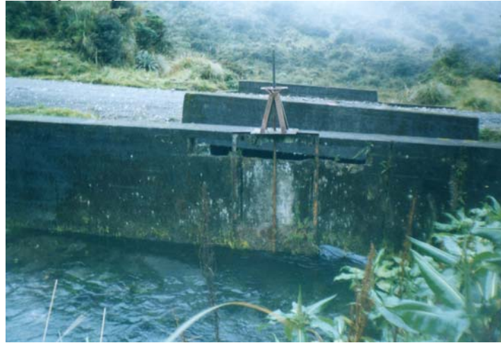
Figura 4. Presa, válvula y compuerta, vista lateral.
