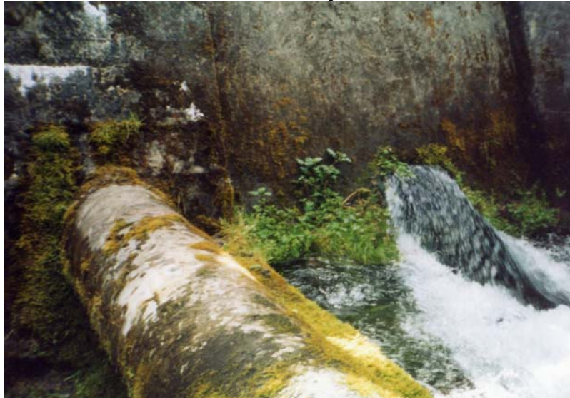
Figura 5. Segmento tubería de asbesto. Bocatoma y aliviadero. Vista frontal
