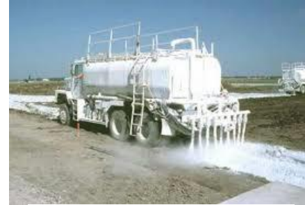
Figura 12 estabilización de suelos Fuente: (Nacional Lime Association, 2004)
