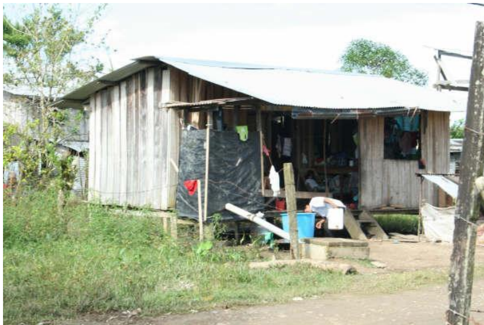
Foto 2. Vivienda de población desplazada.
