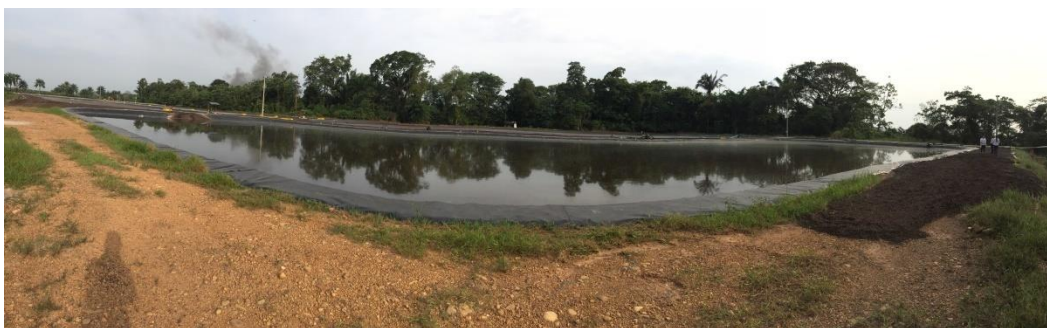
Figura 17. Laguna de oxidación anaerobia (Hacienda La Cabaña)
