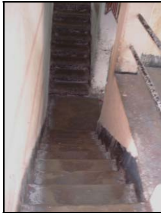
FOTO 57: Amplitud de Escaleras
