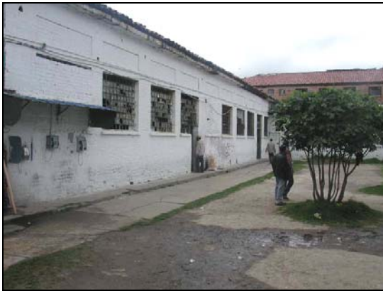
FOTO 21: Muros de Doble Altura
