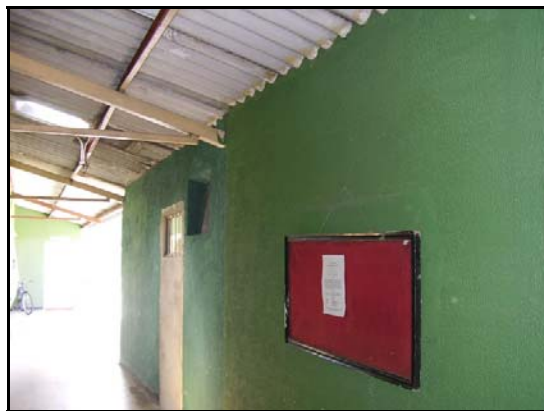
FOTO 3: Tejas y Cerchas
