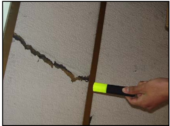
FOTO 8: Cielo Raso en Lana de Vidrio
