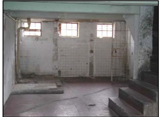
FOTO 56: Vigas y Columnas
