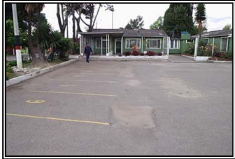
FOTO 87: Parqueadero Área Administrativa
