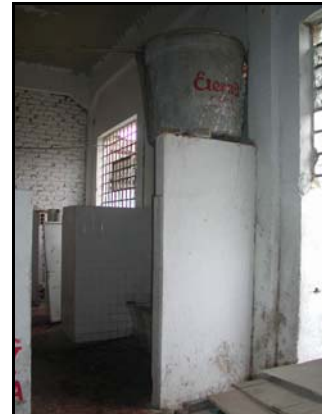
FOTO 72: Soporte de Tanques
