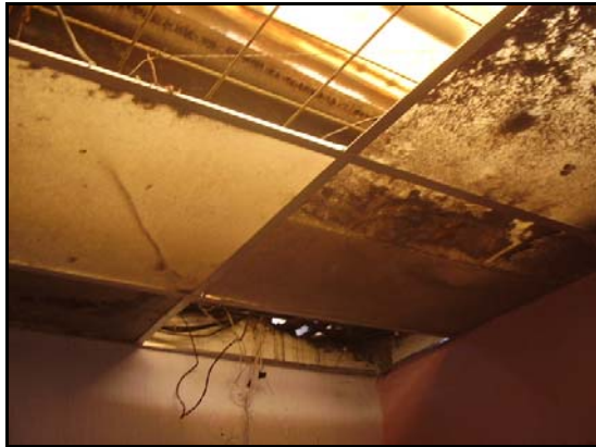
FOTO 7: Cielo Raso en Acrílico
