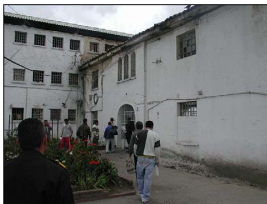
FOTO 28: Reducción de Ventanas
