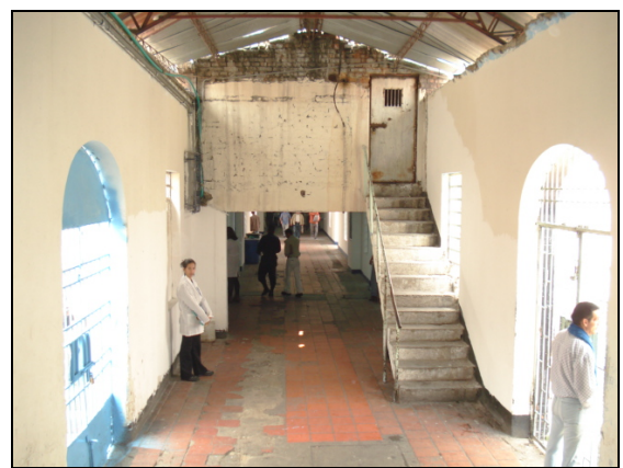
FOTO 52: Celdas de Aislamiento
