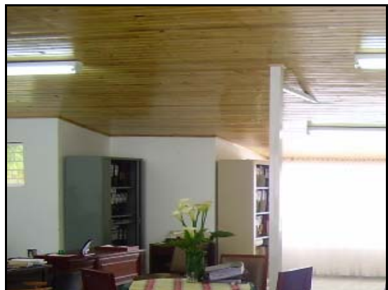
FOTO 6: Cielo Raso en Madera
