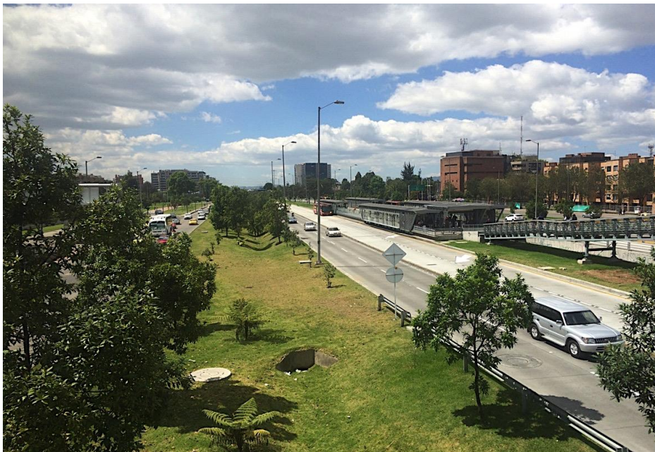
Fotografía 4. . Condiciones Estructurales Calle 26 (área de referencia).
