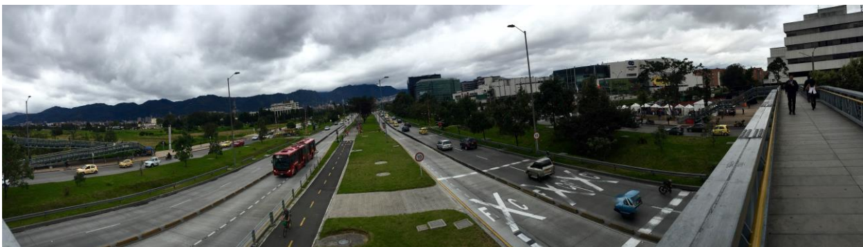
Fotografía 2. Panorámica de la Calle 26 a la altura de la altura de la estación Salitre-El Greco.
